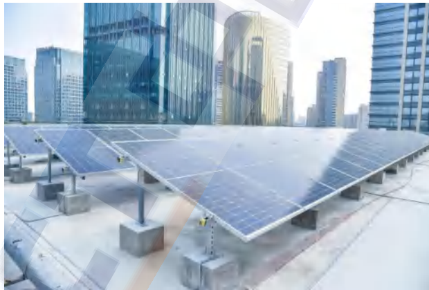
图 10 某数据中心楼顶光伏板
